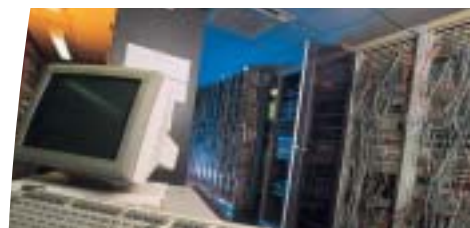
Intégration dans les racks à haute densité.
