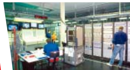
Process industriels : automates programmables, processeurs de variateurs de vitesse...
