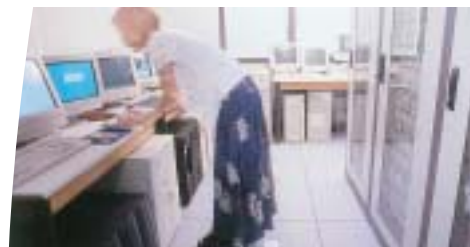
Serveurs et stockage de données, éléments actifs de réseaux...
